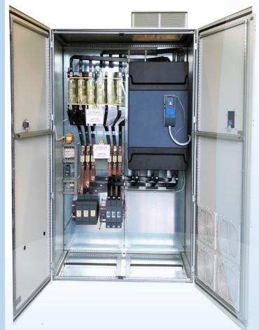
QUADRO DI COMANDO CON INVERTER DA 355KW PER LA GESTIONE DI UN COMPRESSORE
